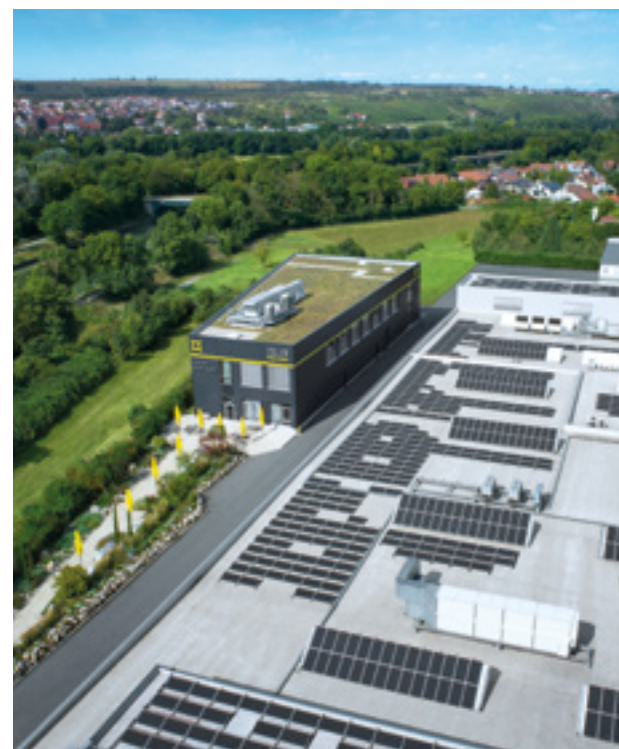
Impianto fotovoltaico sul tetto della sede centrale
