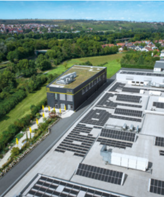
Installation photovoltaïque sur le toit du siège social
